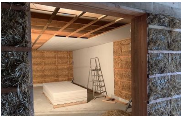
Précieuse chambre froide pendant sa construction.
